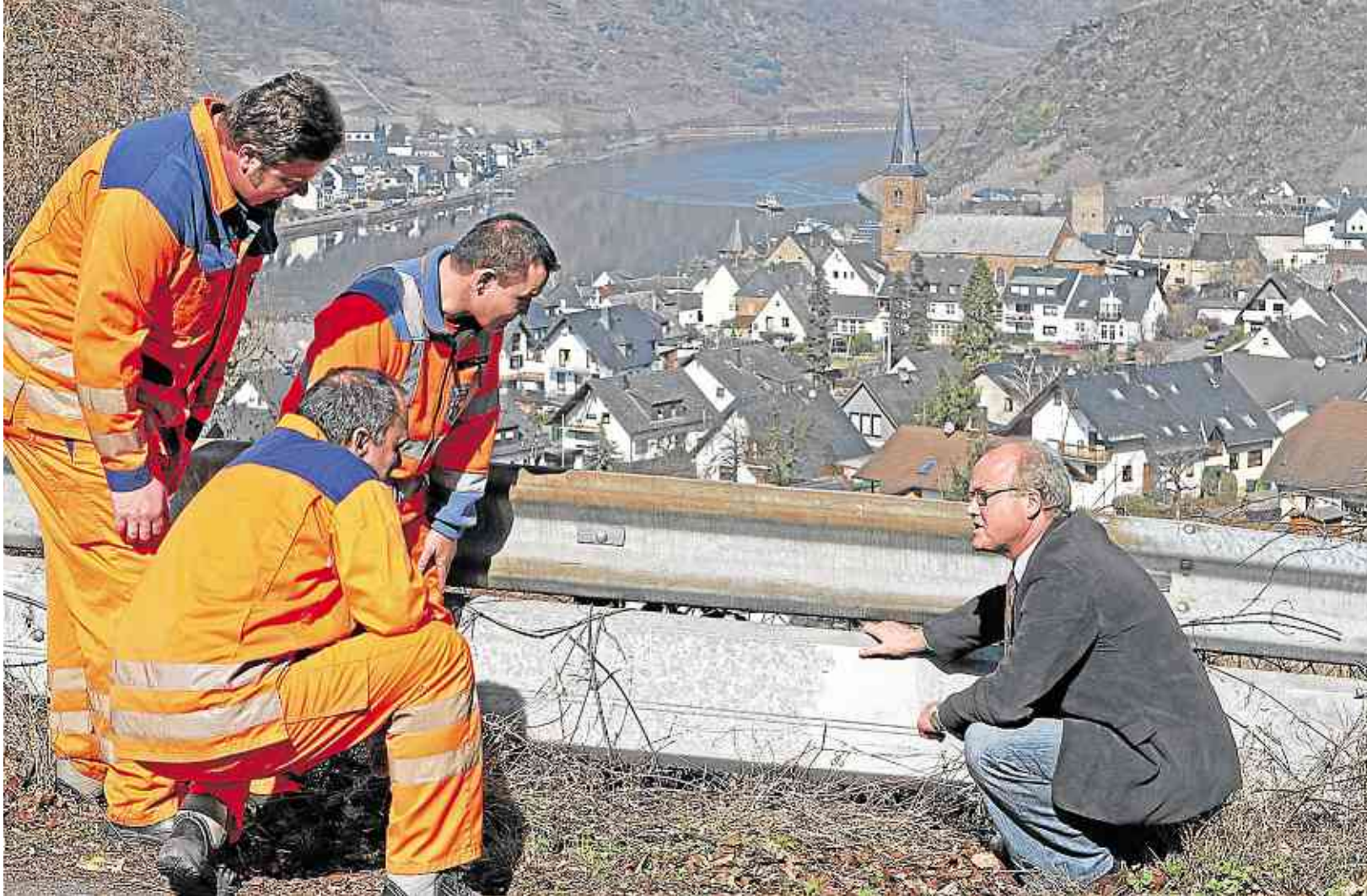
Ein Stück verzinktes Blech, das Leben retten kann: Ferdinand Schmitz, Ausbildungsleiter des LBM, zeigt Streckenwarten einen Motorrad-Unterfahrschutz an der L 207, die bei Alken vom Hunsrück hinunter ins Moseltal führt.
